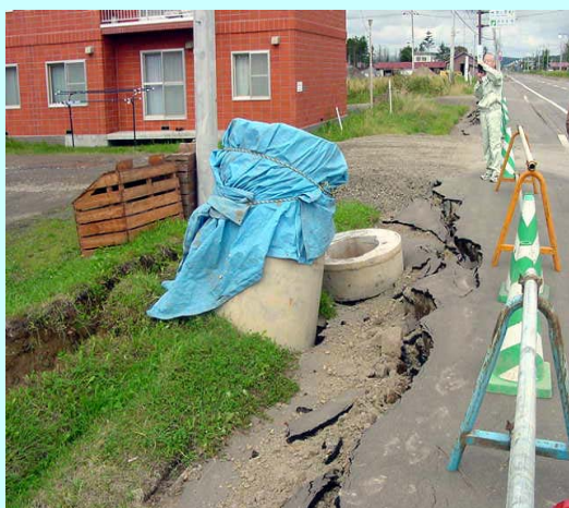
約1.5m突出した北側のマンホール（十勝沖・音別町川東地区）
