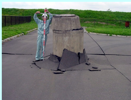
敷地内のマンホールの突出（十勝沖・大津下水浄化センター）
