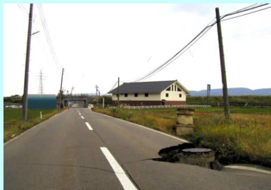
国道403号沿線（中越・小千谷（おじや）市吉谷）の下水道マンホール浮上
